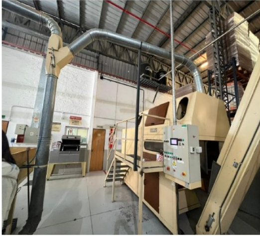
Maquinaria para la etapa de tratamiento superficial
